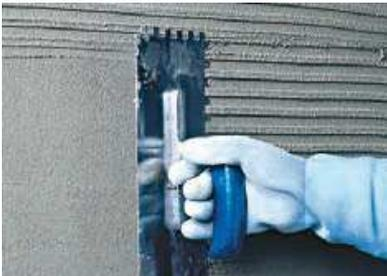
Mit grober Zahntraufel (Zahnung ca.10 mm) als deckende Rillenspachtelung horizontal aufziehen. Schichtdicke an den Stegen ca. 5 mm in den Tälern ca. 2 mm. Um einen optimalen Haftverbund zu erreichen sollte der maxit multi 262 gut ansteifen und nach 24 Stunden (bei Normalbedingungen +20°C / 65% Luftfeuchte) mit den maxit Kalk-, Kalkzementputzen weiterbeschichtet werden.
