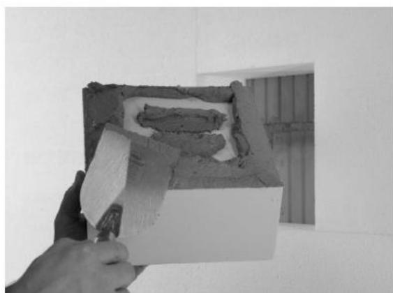
maxit Quadroline Montagequader dämmplattenbündig anpressen.
