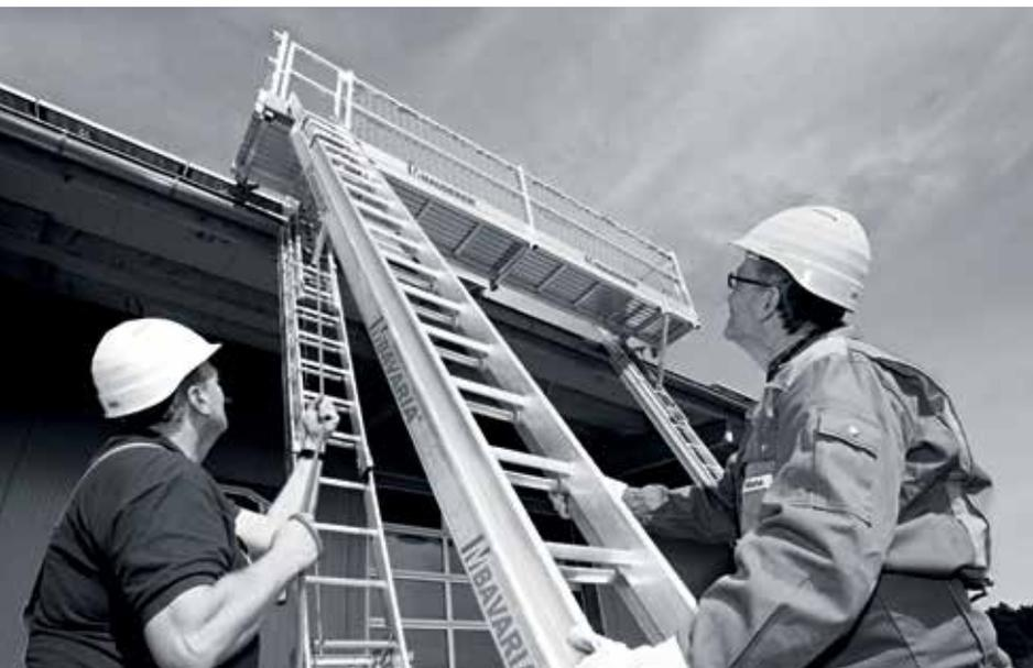
Unsere BAVARIA-Absturzsicherungen erfüllen die Schutzklassen der DIN-Normen EN13374 und sind eine Zeit sparende Lösung für alle Arbeiten auf dem Dach.
