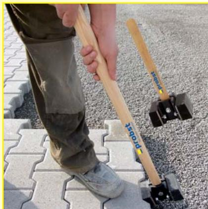
Noch nicht abgerüttelte Beläge lassen sich damit an den Kanten schnell und einfach ausrichten
