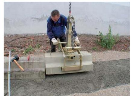
... beim Versetzen von schweren Bordsteinen und Betonelementen: mechanisch, kraftvoll und sicher – Fertigteilzange FTZ-UNI
