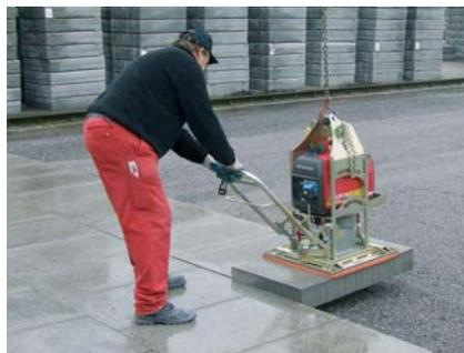
... beim Verlegen von großen und schweren Platten: Kraftvoll und sicher, auch bei porösen Platten – QUICKJET QJ-600-E – Vakuum-Anbaugerät.
