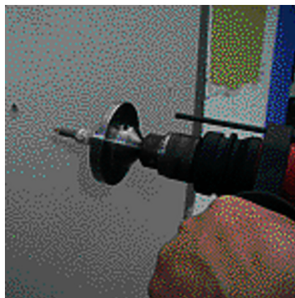
HASIT Putzfräser (Art.-Nr. 012143) zur Erstellung von zusätzlichen Bohrungen zur Aufnahme der Dübelteller
