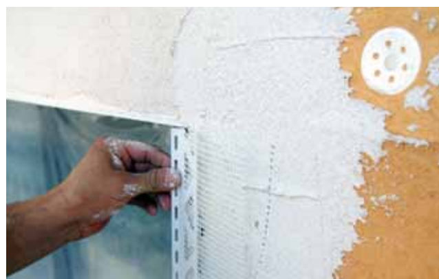
Aufbringen der Putzbeschichtung
