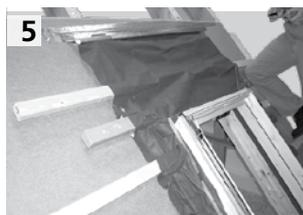
Befindet sich direkt über dem Dachflächenfenster ein Vertikalstoß, muß dieser mit PAVATEX-Dichtprodukten abgeklebt werden (Abb.9 auf Seite 22)
