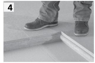
Die stabile Nut- und Feder-Verbindung sorgt für eine fugengeschlossene Dämmschicht die zur Wärmebrückenminderung beiträgt.
