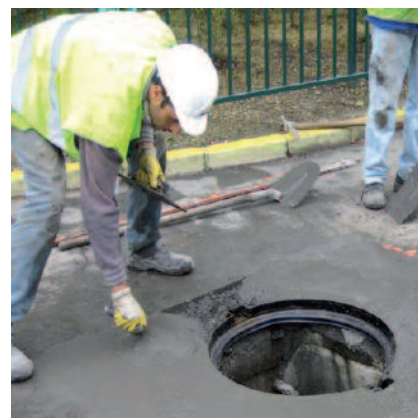
Einbetten eines Schachtringes mit PCI Repafast Fast Tixo
