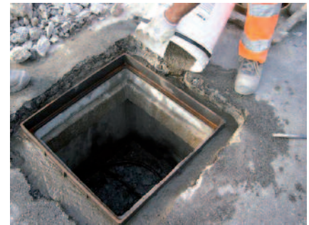
Ausgiessen eines Kanalschachtrahmens mit PCI Repafast Fluid.
