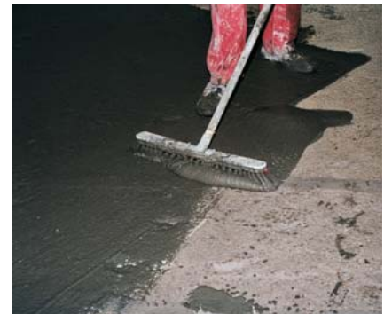
PCI Repahaft wird auf den Untergrund aufgebürstet. Der Estrichmörtel wird sofort danach auf die frische Haftbrücke aufgetragen.
