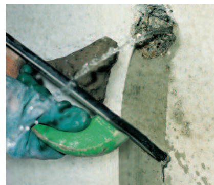
Mit dem Blitz-Montage-Mörtel PCI Polyfix 30 Sek. können Wassereinbrüche schnell gestoppt werden.
