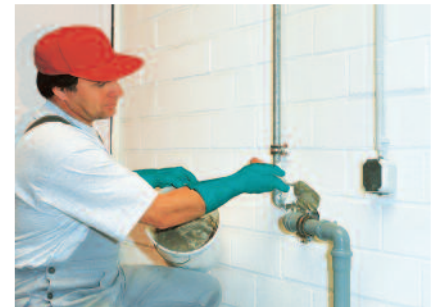
Der Blitz-Zement-Mörtel PCI Polyfix 5 Min. ist leicht zu verarbeiten und nur mit Wasser anzumischen.
