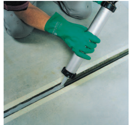
...die Bodenfugen mit PCI Elritan 140 schließen.
