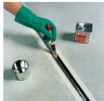
Vor dem Verfugen die gereinigten Fugenflanken mit PCI Elastoprimer 110 bis zur Sättigung mit einem Pinsel grundieren. Nach einer Ablüfzeit von min. 50 Minuten und max. 2 Stunden...
