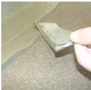
Klebeband entfernen (unten)
