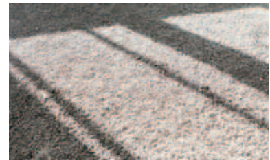
Vor dem weiteren Fußbodenaufbau ist auf eine ausreichende Austrocknung zu achten.
