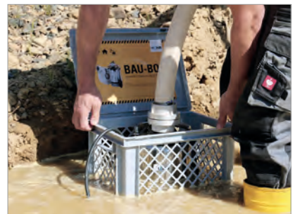
Der Tragekorb fungiert bei Bedarf als Vorfilter
