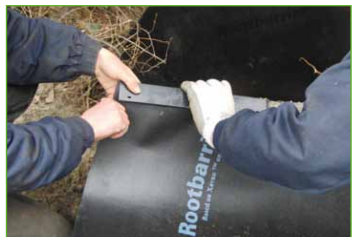
Das Anbringen des Clicks bei einem Projekt in Rotterdam.
