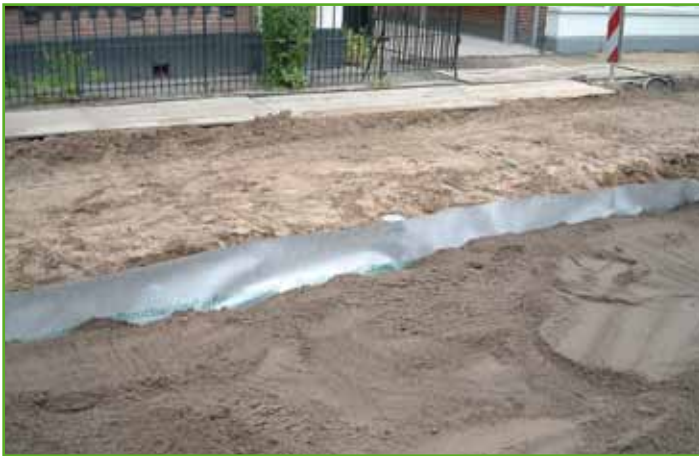
RootBarrier® 325 eingesetzt 2003 in Amersfoort
