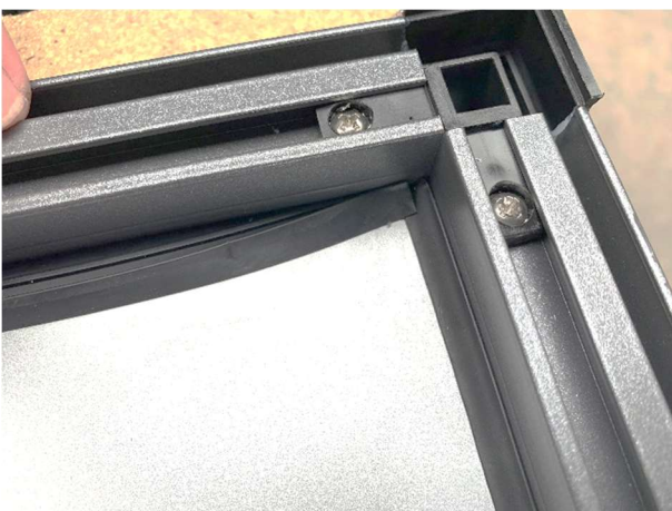
5. Detailansicht: Ein Ende der Keildichtung im Profil
