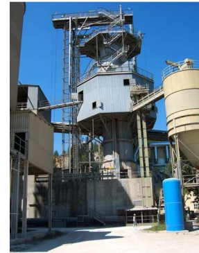
Hochofen zum Brennen von Branntkalk
