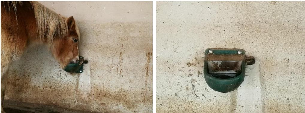
*Abbildung 1: Pferdetränke direkt angeschlossen an die Trinkwasser-Installation, Quelle Kiefer*
