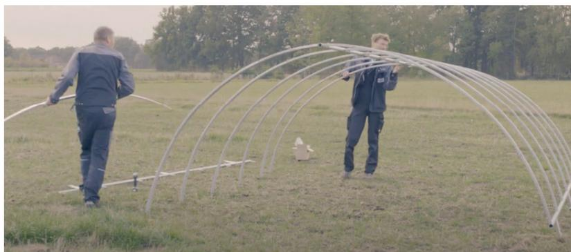
Die Dachbögen in die Rahmenrohre einführen
