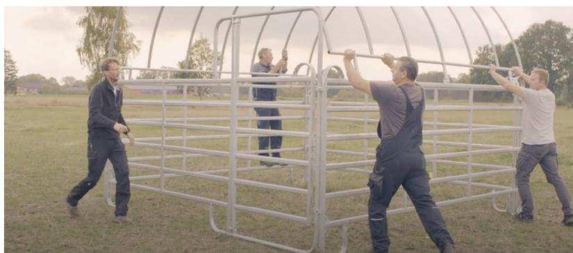
Dachkonstruktion am besten mit vier Personen an den Panels befestigen.
