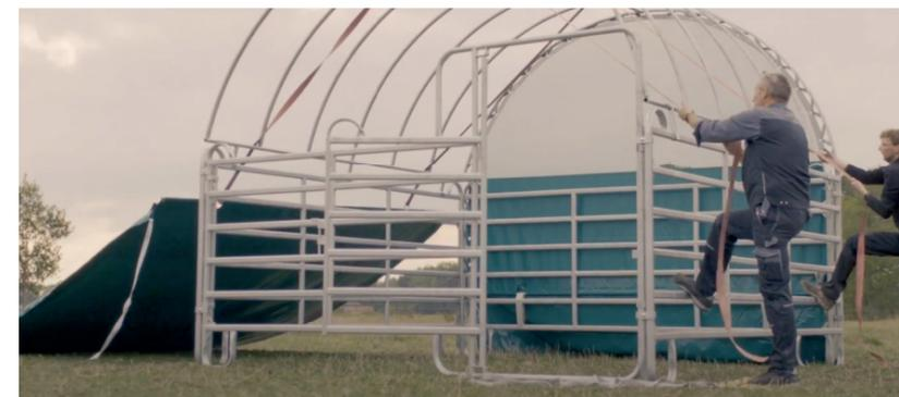
Mithilfe von zwei langen Spanngurten mit Haken (nicht im Lieferumfang enthalten) die Plane gleichmäßig über die Dachkonstruktion ziehen.
