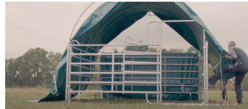
Das letzte Abspannrohr einfädeln und fixieren.
