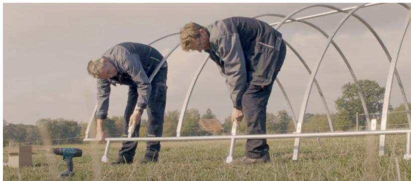
Die Dachbögen mit den Rahmenrohren verschrauben
