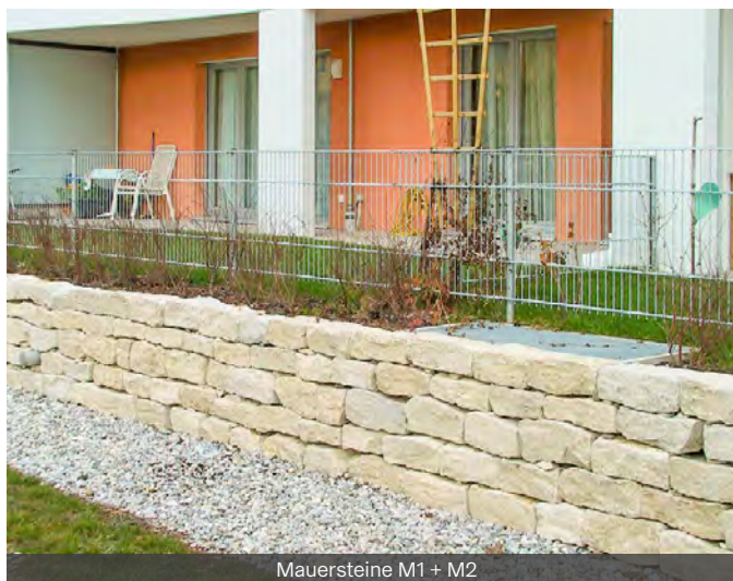
Mauersteine M1 + M2
