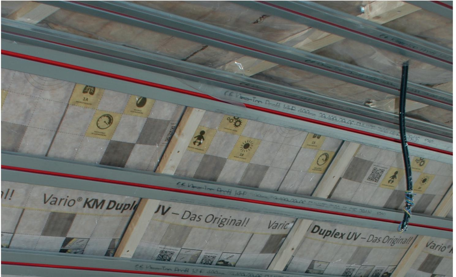
Bei Dachschrägen kann der vorgegebene Profilabstand in die Dachschräge projiziert werden. Da der Profilabstand in der projektspezifischen Auslegung auf die horizontale Fläche des Raums ausgelegt ist, vergrößert sich der Profilabstand in der Dachneigung.
