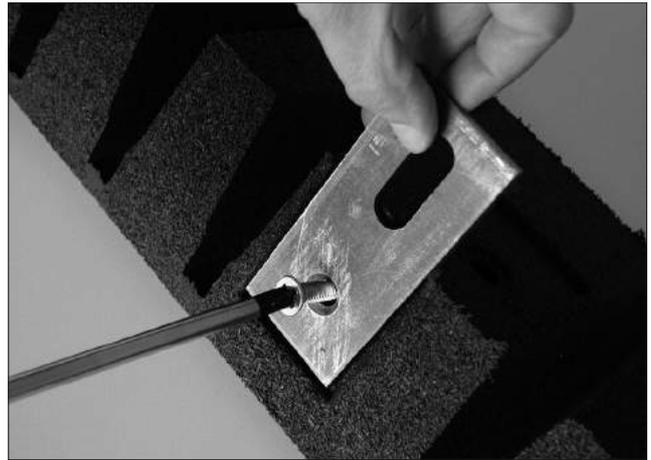
**2** Unterschraubplatten auflegen und mit Turboschrauben am Elastikbordstein befestigen.
