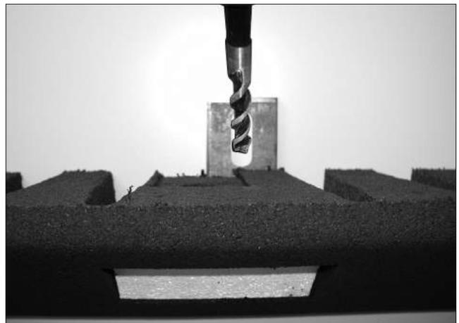
**4** Dübellöcher mit Bohrer (12 Ø) ca. 110 mm tief bohren, Bohrstaub aussaugen oder ausblasen.
