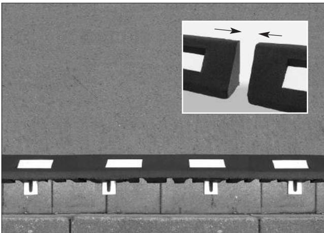
**3** Elastikbordsteine stirnseitig mit Loctite nach Verarbeitungsanleitung verkleben und am Objekt ausrichten.
