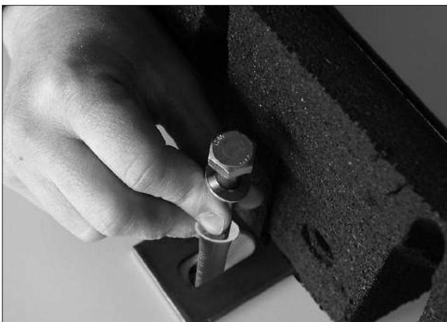
**5** Dübel mit Schraube und Unterlegscheibe durch die Unterschraubplatte stecken.
