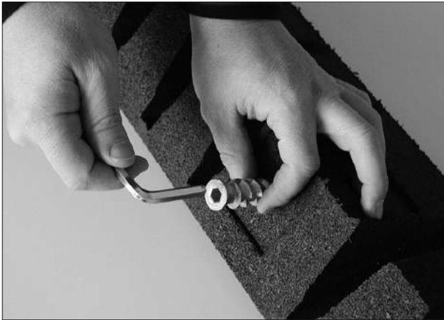
**1** Einschrauben der Aludübel in die Unterseite des Elastikbordsteines.
