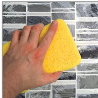
Laisser le coulis durcir de 20 à 30 minutes. À l'aide d'une éponge en cellulose légèrement humide, désagréger l'excès de coulis des carreaux par mouvements circulaires. Ne pas ajouter d'eau jusqu'à ce que le tout soit bien désagrégré.
