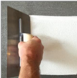
Étaler une couche d'adhésif en utilisant le côté dentelé de la truelle et strier des lignes droites sur la surface de manière à obtenir une répartition uniforme. Sur les murs, strier l'adhésif dans le sens horizontal.
