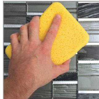
Pour faciliter le jointoiment, humecter légèrement la surface du carreau avec une éponge mouillée, juste avant l'application. **Remarque :** Le temps de travail et la facilité de nettoyage peuvent considérablement être prolongés (jusqu'à 2 heures) lorsque le PRO GROUT™ EASE de PROMA est utilisé comme protection temporaire avant le jointoiment.
