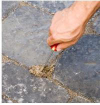
**5-** Vérifier la progression du mouillage en creusant les joints en plusieurs endroits. L'objectif est de mouiller le joint à un minimum de 4 cm (1,5 po) de profondeur;
