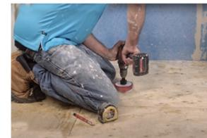
**3.** Positionnez le plateau de douche AlinO et marquez le sous-plancher pour indiquer la position du trou pour accéder à la sortie du tuyau. Retirez le plateau de douche et coupez un trou de 4-1/2 po de diamètre à l'aide d'une scie sauteuse ou d'une scie cloche et couvrez la sortie du drain pour la protéger des débris.
