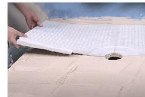
**4.** Nettoyez le sous-plancher avec un chiffon humide et étendez du mortier à prise mince modifié à l'aide d'une truelle crantée en V 1/4" x 1/4" et positionnez le plateau de douche AlinO (côté plat face vers le bas). Assurez une couverture de mortier à 100% à l'arrière du plateau.
