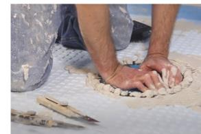
**6.** Installez le corps du drain avec du mortier mince modifié sur le plateau de douche. Appuyez sur le corps du drain et maintenez-le pendant quelques secondes pour lier correctement le connecteur du drain à la sortie du tuyau de vidange. Retirez l'excédent de mortier sur le dessus de la bride du drain et couvrez le trou du drain avec un chiffon pour le protéger des débris.
