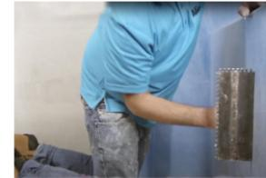
**1.** Installez les joints AlinO Seals et la membrane imperméable AlinO-Gard sur le mur en appliquant du mortier à prise mince modifié à l'aide d'une truelle crantée en V 3/16" x 3/16". Assurez-vous qu'il y a un chevauchement de 2 po à chaque joint, une couverture de mortier à 100% à l'arrière, puis d'éliminer toutes les poches d'air.
