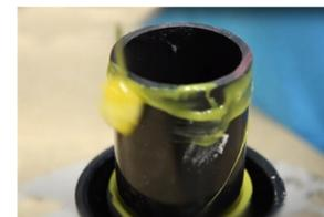
**5.** Retirez le couvercle de la sortie du tuyau et connectez le corps du drain AlinO à la sortie du tuyau en utilisant de la colle ABS / PVC (il peut être nécessaire d'ajouter un petit tuyau ABS / PVC s'il y a un espace entre le connecteur du drain et la sortie du tuyau).
