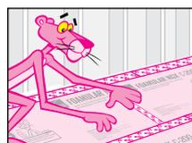
**2. INSTALLATION DE L'ISOLANT CODEBORD<sup>MD</sup> OU C-200** Assurez-vous que les panneaux sont bien jointifs. Il est recommandé de sceller tous les joints avec le ruban à joints JointSeal<sup>MD</sup> approuvé de Owens Corning<sup>MD</sup>.
