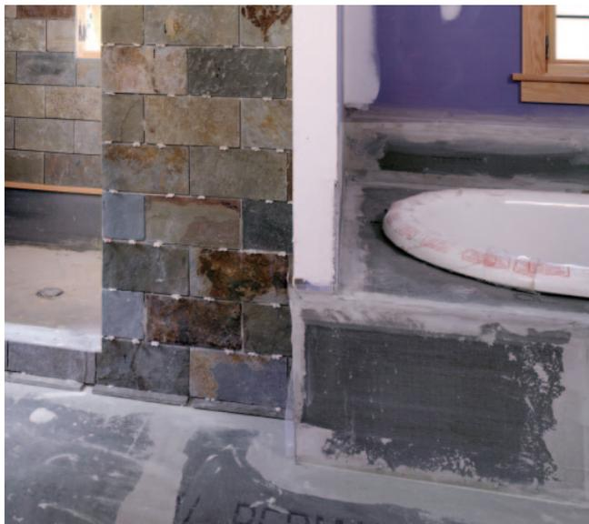
pas excéder 406 mm (16 po). (Les bords des panneaux PermaBase qui sont parallèles à la charpente doivent être appuyés sur toute leur longueur.) Installer des cales supplémentaires au besoin afin que les panneaux soient solidement fixés.
