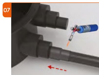
Skyv den tidligere monterte krympemansjetten over det prisolerte røret og UICens endeåpninger. Bruk vernehansker og varm krympemansjetten forsiktig opp, og press mansjetten på mantelrøret og på UICens endeåpninger.
