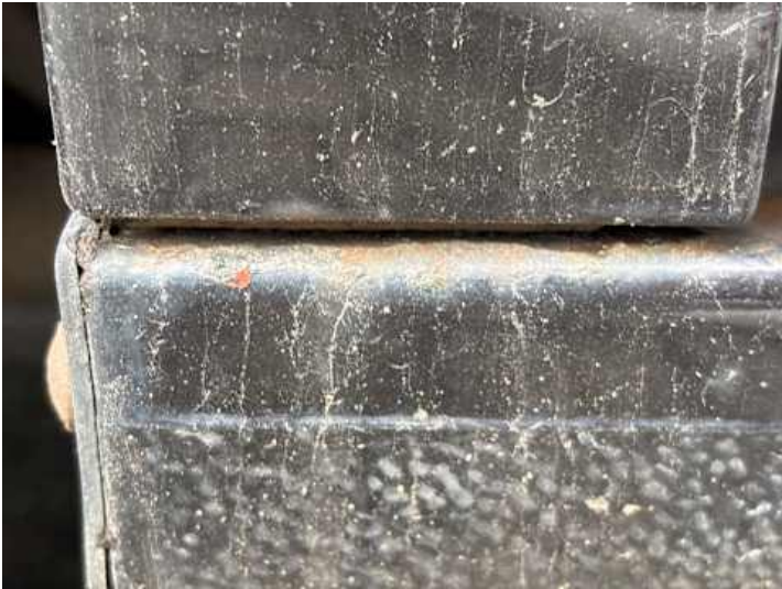
Schweller links (Rost)
