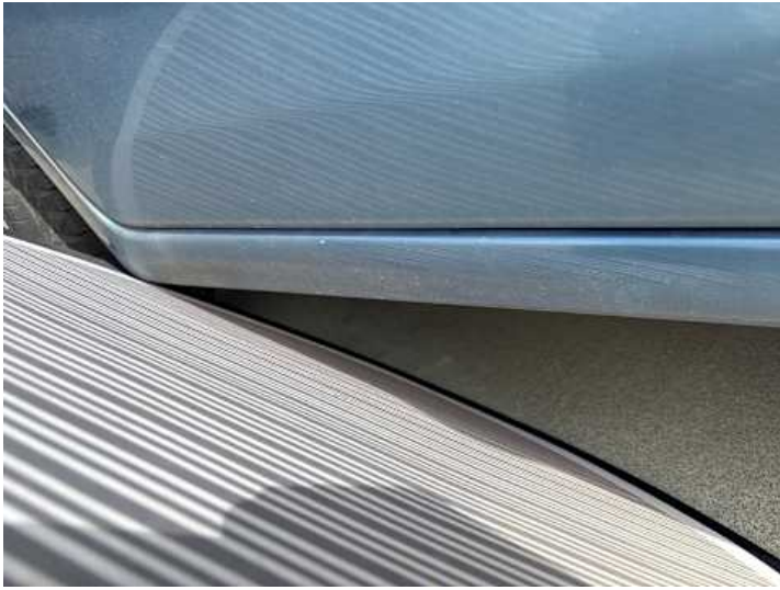
Schweller rechts (Verformung)
