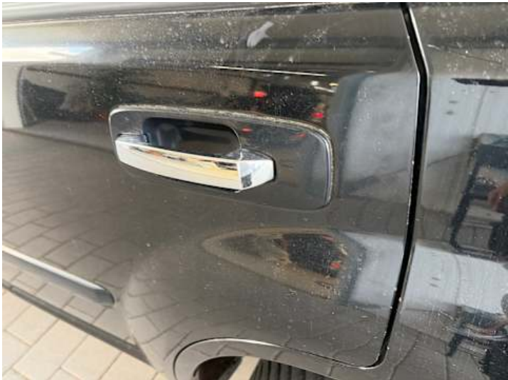
Türe hinten links (Kratzer, Delle)
