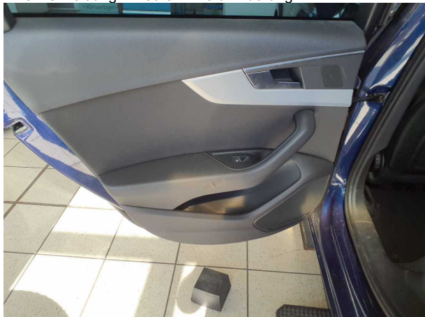
Beschädigung #3: Verkleidungen/Abdeckungen: Türverkleidung hinten links - Delle(n) - Wertminderung
