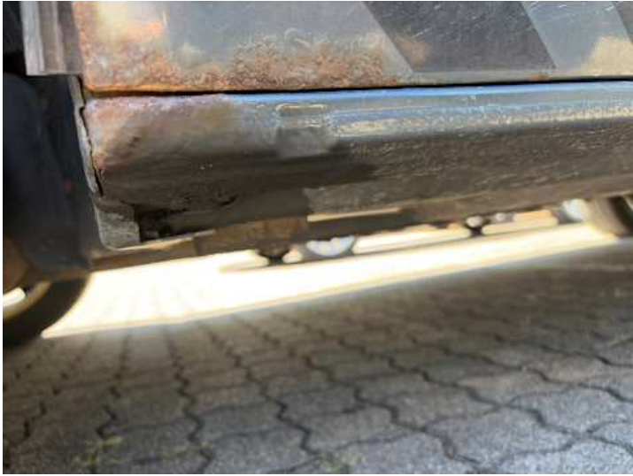
Schweller links (Rost)
