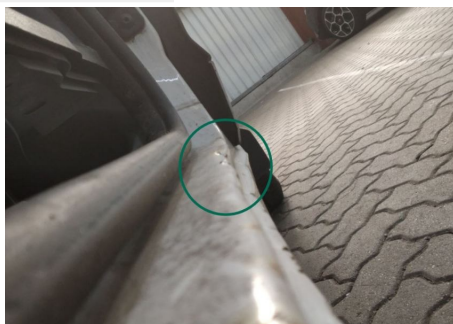
Schweller / Rechts / Delle
