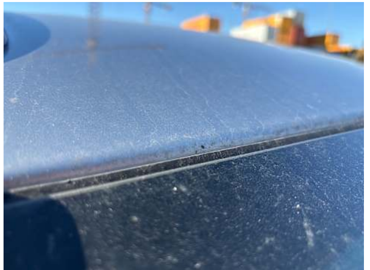
Dach (Rost, Steinschlag)
