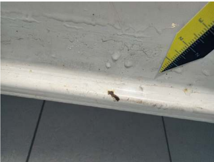
Schweller links (Kratzer, Rost)
