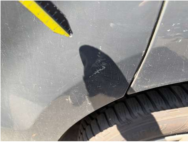
Türe hinten links (Lackschaden, Kratzer)
