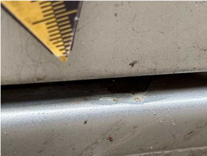
Schweller links (Rost)
