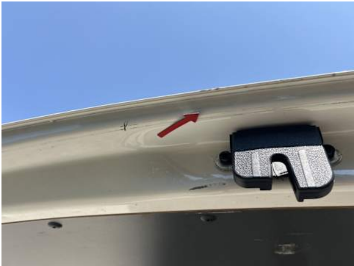
Heckklappe (Kratzer, Rost)
