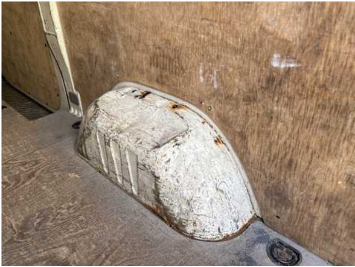
Innenraum (Diverse Schäden)
