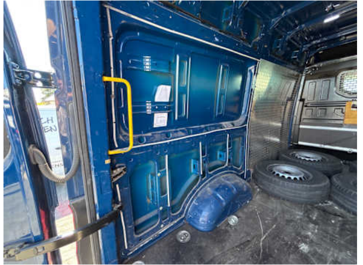
Innenraum (Anderer Schaden): Verkleidung fehlt,
