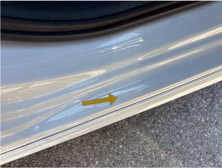
Schweller rechts (Lackschaden, Unsachgemäß instand gesetzt, Kratzer)
