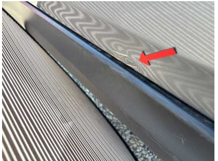
Fahrtür (Kratzer, Rost, Verformung)
