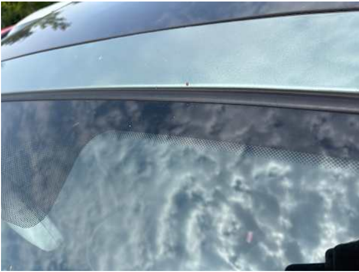
Dach (Steinschlag, Rost)
