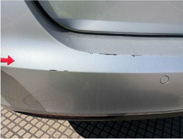
Stoßstange hinten (Lackschaden)
