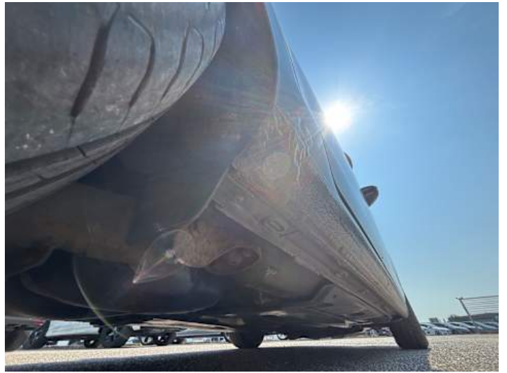
Schweller rechts (Rost)
