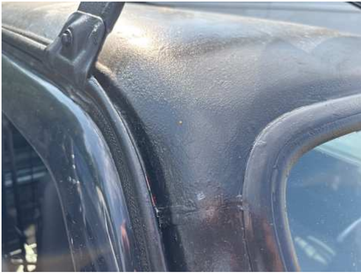
Dach (Lackschaden, Unsachgemäß instand gesetzt)
