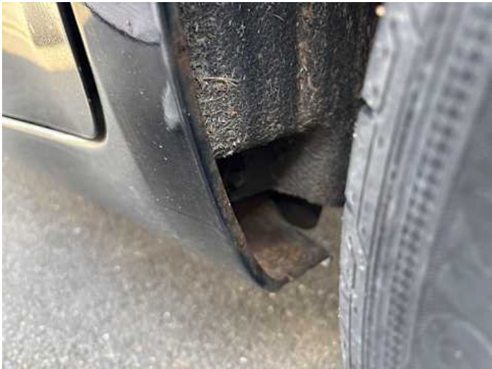
Schweller links (Rost)
